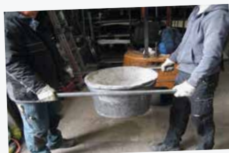
Selbst gebaute Transporthilfe für Speißfass
