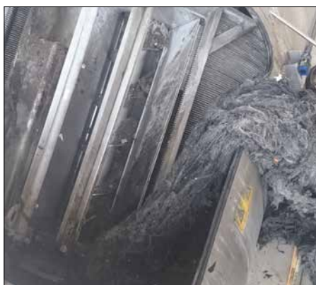
Ein »Abwasserzopf« wie dieser verstopft Pumpen und macht auch im Klärwerksrechen Probleme.
