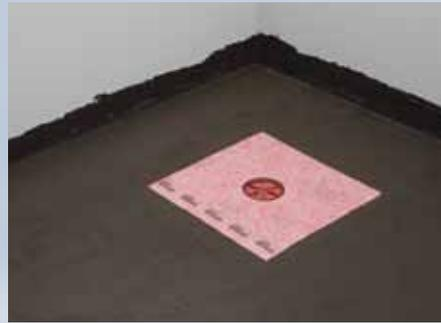
Die getrocknete erste Schicht der Verbundabdichtung mit einer eingelegten Seal System Dichtmanschette. Diese wirkt als verbindendes Element zwischen Verbundabdichtung und Punktablauf.
