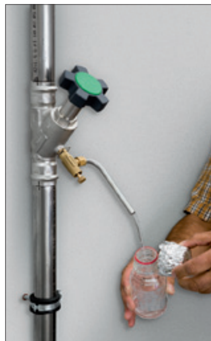
Beprobung gemäß der TrinkwV 2011 mit Viega Probennahmeventil
