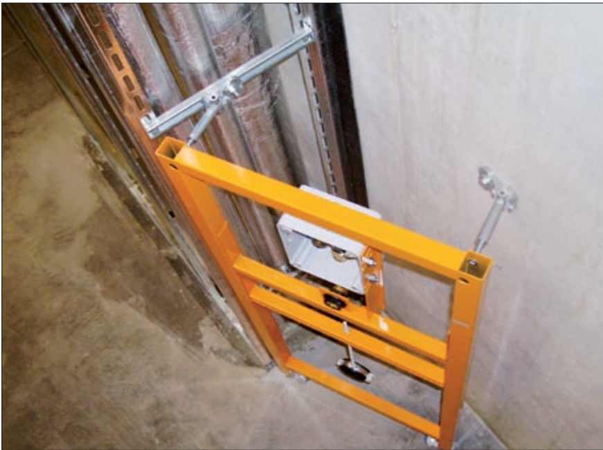
JOMO TGA-Baureihe mit schwenkbaren Wandhaltern
